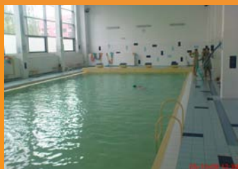
ZŠ Gen. Píky - rekonstrukce pavilonu E
