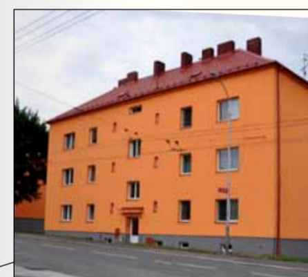
DPS ul. Heřmanická, Slezská Ostrava
