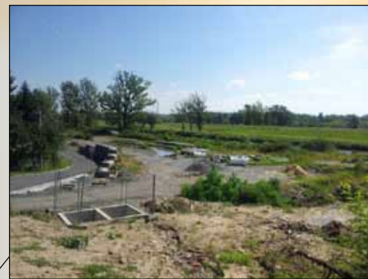
Stavba protipovodňové hráze, Koblov
